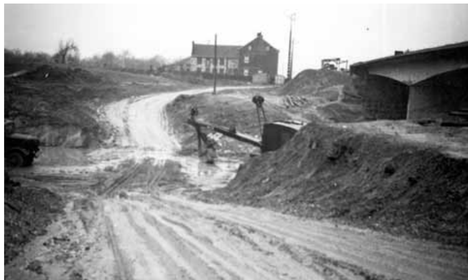
Rechts: Bau der Autobahn an Windmühle, im Bild Haus Knops. Links anlässlich der offiziellen Einweihung im Jahre 1963 Bundespräsident Lübke und König Baudouin I. (oben).
