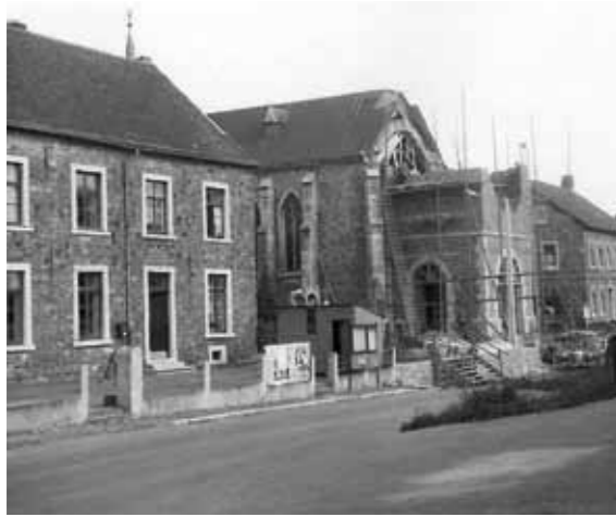
Links: Der Kirchturm, hier ein weiteres Foto aus der Bauzeit, wurde 1962 eingeweiht.
