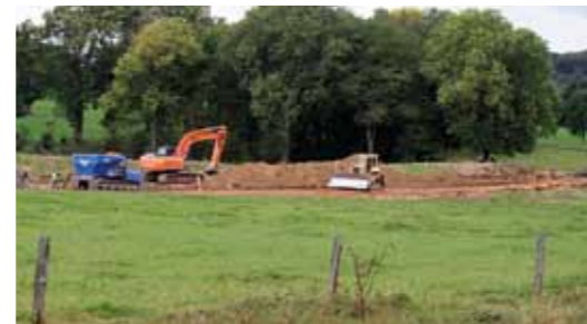
Unmittelbar daneben wurde 2011 die neue transnationale Gasleitung verlegt.
