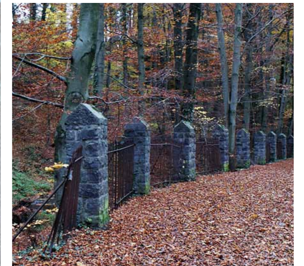
An der Abzweigung zur Göhlbrücke und zur Burg drehte die Bahnstecke rechts ab. Sie verlief dort entlang, wo der spätere Burgherr Nellessen das Eisengitter errichten ließ.
