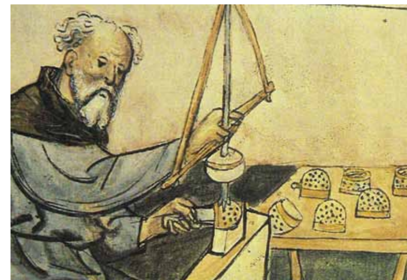
Bild 13: Der Fingerhüter bei der Arbeit mit der Dreule (Drillbohrer) zur Herstellung der Vertiefungen. Um 1400, Nürnberg.
