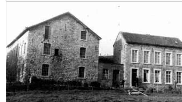
Bild 9: Hauset, die verlassenene Kupfermühle
