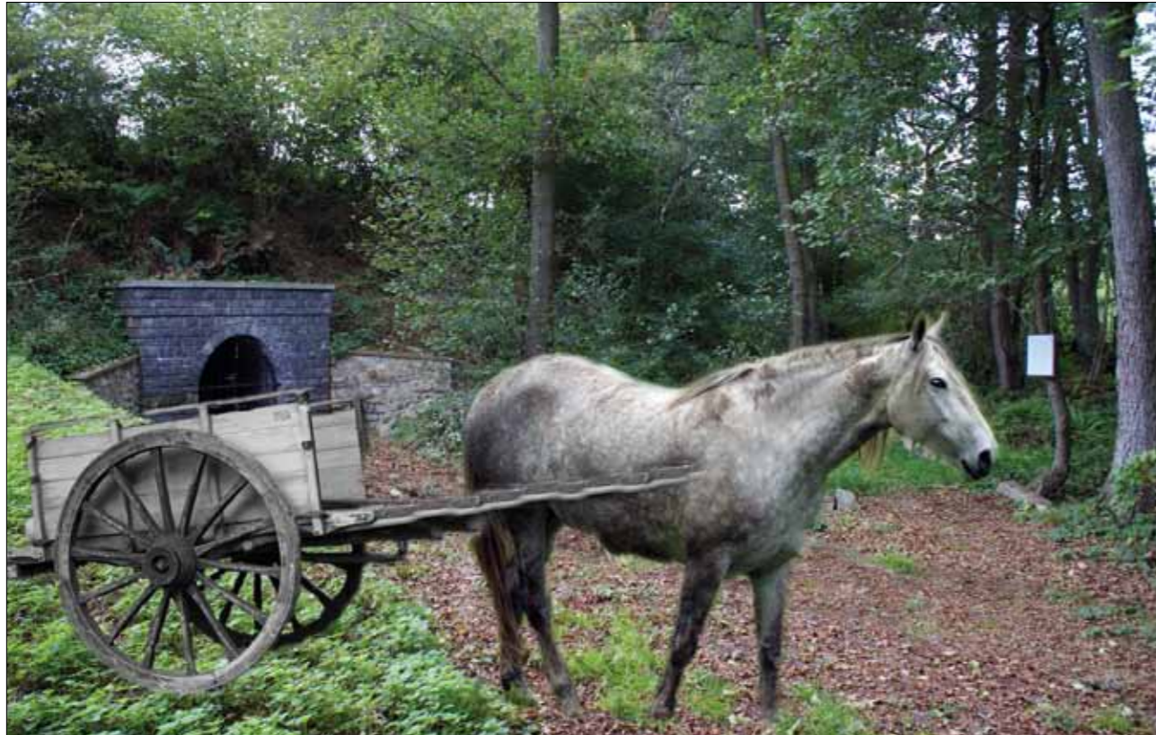
Der restaurierte Ausgang des Luisenstollens. Von hier aus wurde das Galmeierz zuerst mit Fuhrwerken, dann per Pferdebahn zur Aufbereitung nach Kelmis transportiert.
